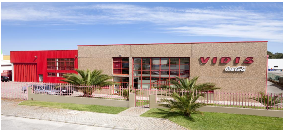
Figura 15: Instalações do Grupo Vidis - Parque Industrial de Coimbra-Visu
