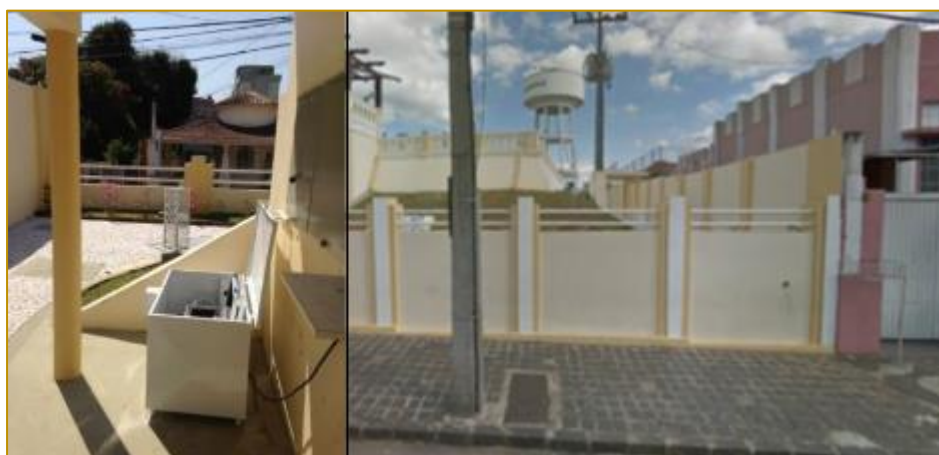
Figura 3 – Local de instalação do amostrador.
