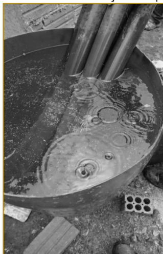
Figura 6 – Tratamento por Substituição de seiva com solução de produtos químicos preservantes.
