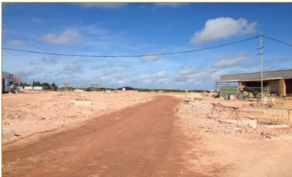
Figura 16 – Acesso com tráfego liberado (Após a manutenção corretiva)
