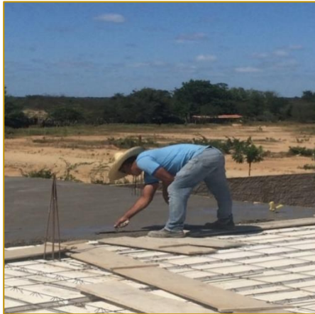
Figura 15 - Posição 2 assumida pelo trabalhador na concretagem da laje
