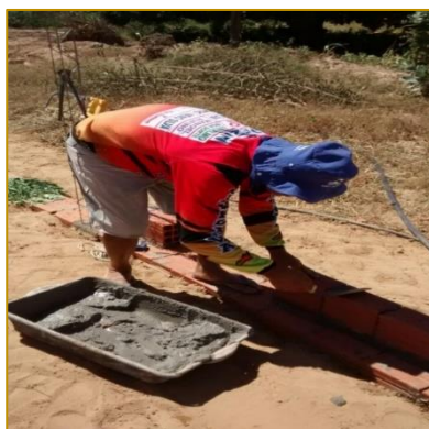
Figura 11 - Posição assumida pelo trabalhador na atividade de levantamento de alvenaria correspondente a zona 1
