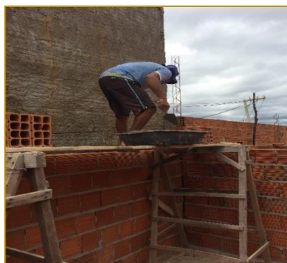
Figura 12 - Posição assumida pelo trabalhador na atividade de levantamento de alvenaria correspondente a zona 3
