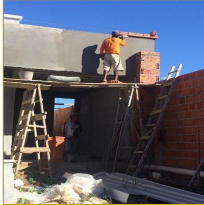
Figura 13 - Posição assumida pelo trabalhador na atividade de levantamento de alvenaria correspondente a zona 2 e zona 4
