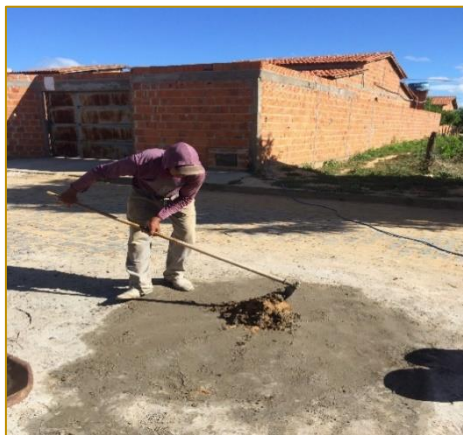
Figura 16 - Postura assumida pelo trabalhador na atividade de preparação da argamassa
