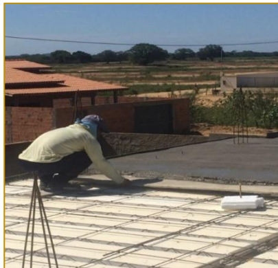
Figura 14 - Posição 1 assumida pelo trabalhador na concretagem da laje
