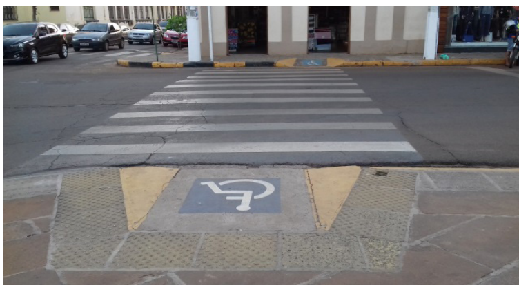
Figura 1: Rampa, pisos táteis e faixas de segurança na Praça XV de Novembro
