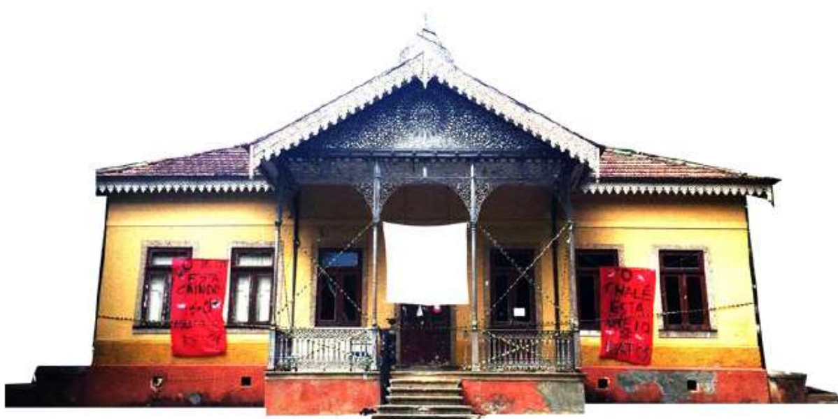
Figura 2. Fotografia Fachada frontal em 2016. Fonte: Autores
