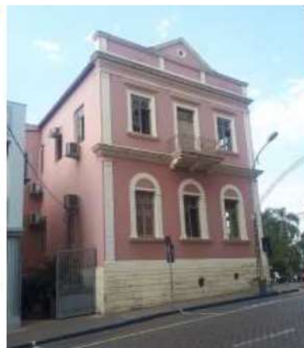
Fachada lateral esquerda – Rua Júlio de Castilhos
