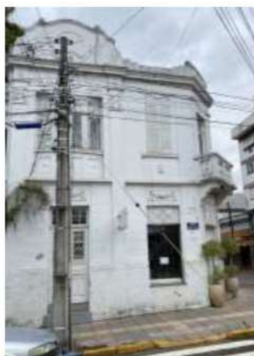
Fachada lateral esquerda – Rua Júlio de Castilhos
