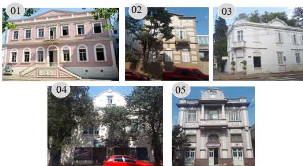
Figura 03 - Fotografias das edificações inventariadas.
